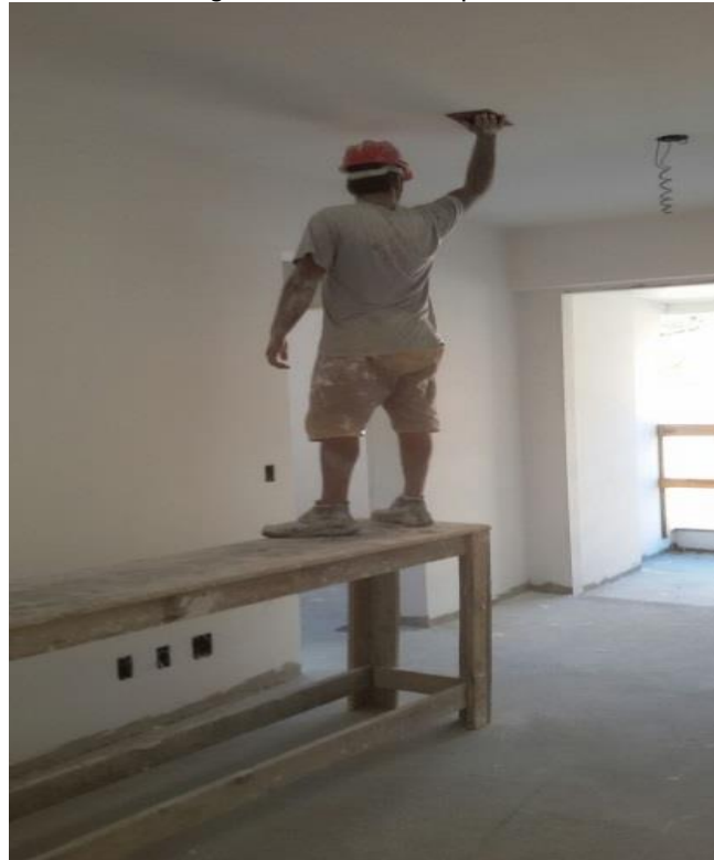
Figura 19 – Setor de pintura
