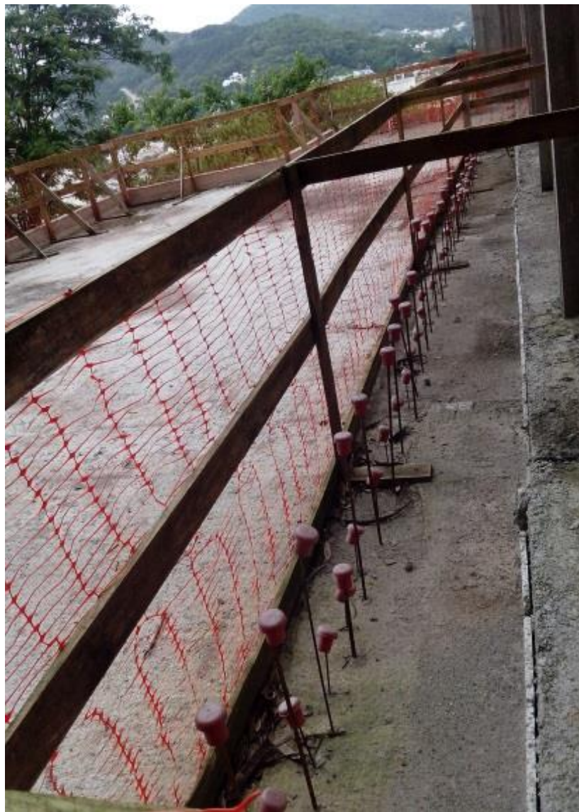
Figura 11 – Vergalhões em conformidade
