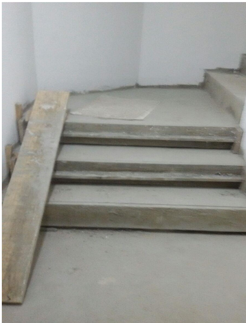
Figura 5 – Restos de madeira nas escadas
