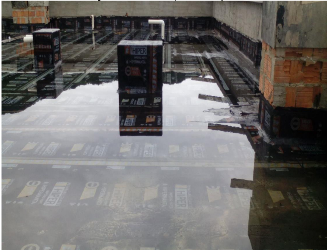
Figura 22 – Setor de impermeabilização 2
