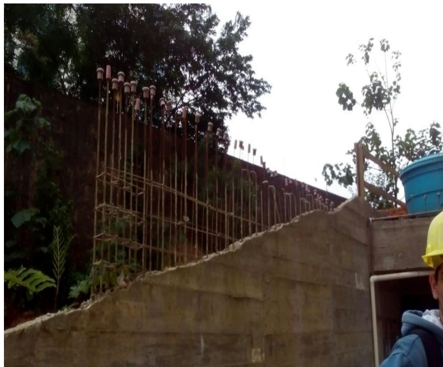
Figura 13 – Vergalhões em conformidade 3
