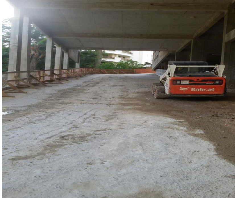
Figura 2– Entradas de máquinas
