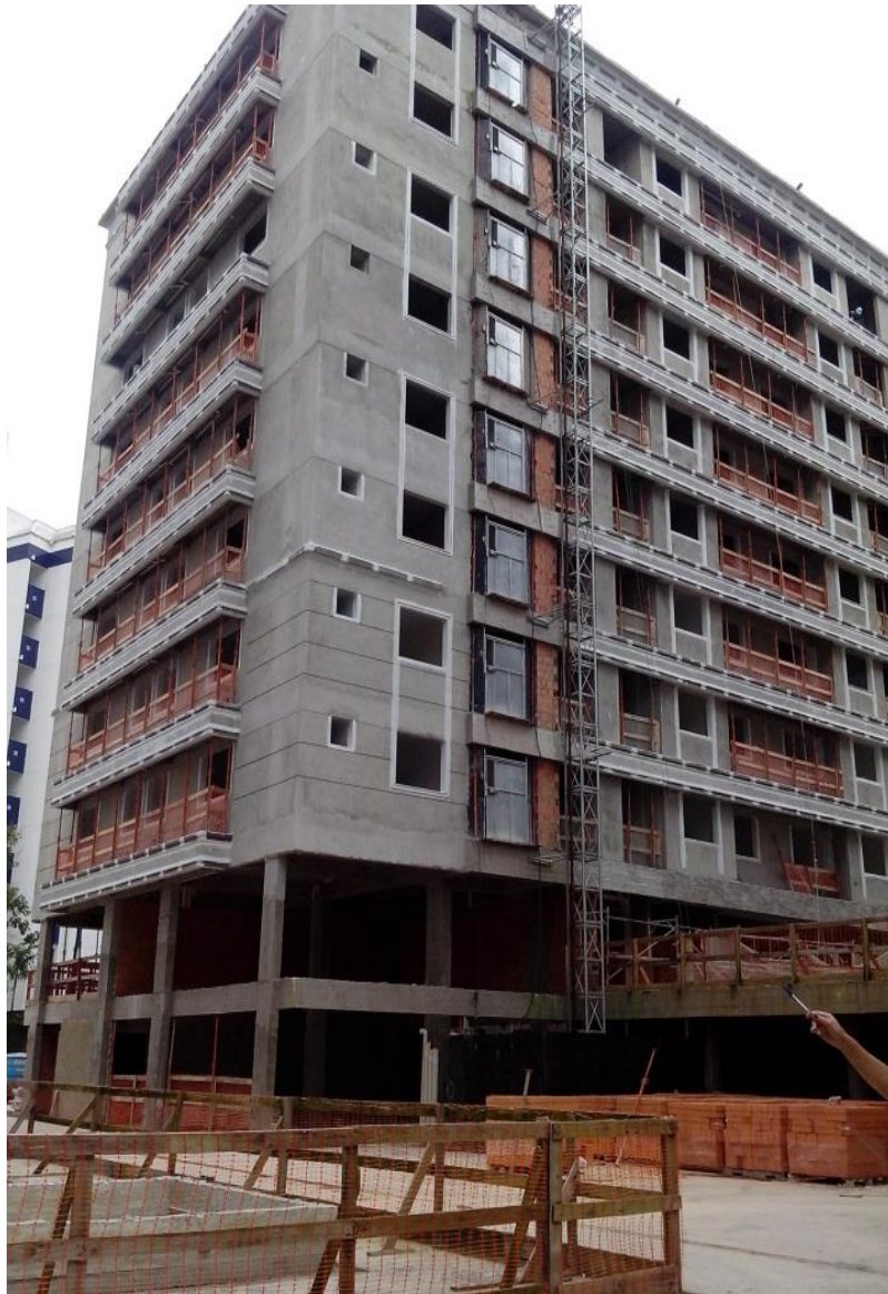
Figura 4 – Vista do entorno das obras
