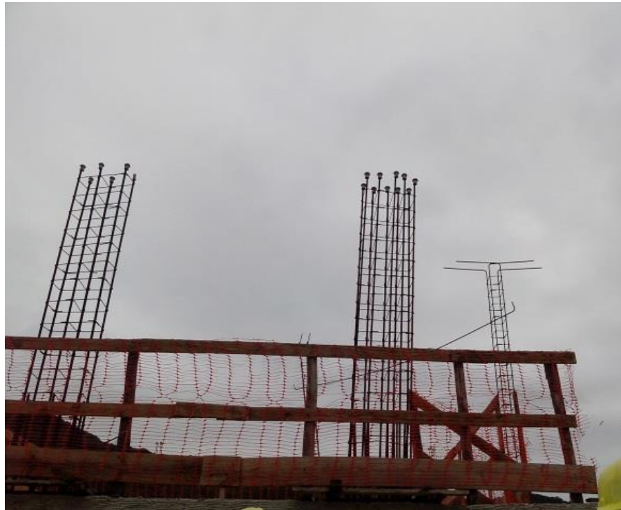
Figura 12 – Vergalhões em conformidade 2
