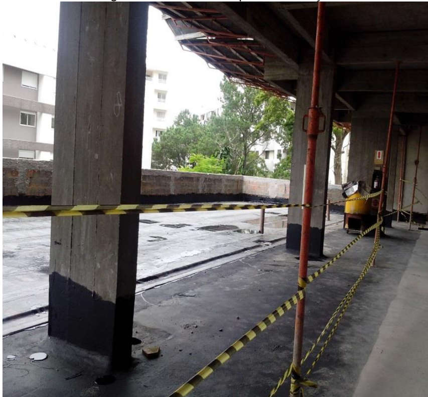
Figura 21 – Setor de impermeabilização
