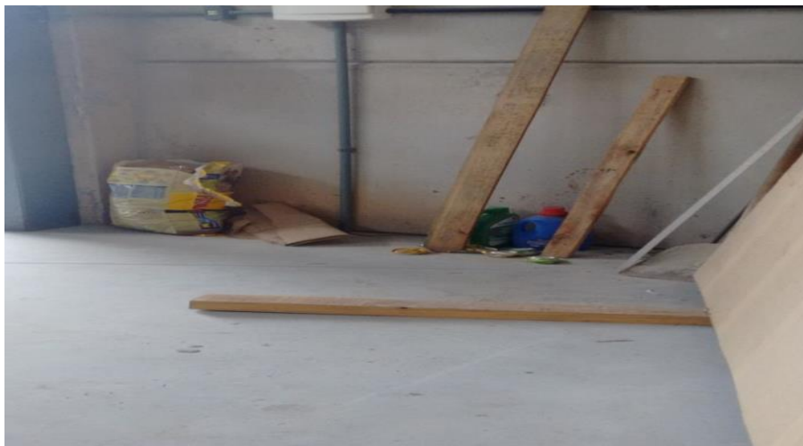
Figura 08 - Madeiras E Produtos De Limpeza Agrupados Em Local Inadequado
